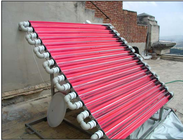
Figura 4.6- Planta piloto de fotocatalisis solar de 25 L
