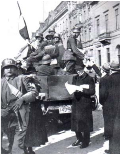
Tropas del "Putsch" con esvásticas en Postdamer Platz, 1920.
