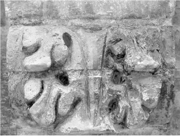
Figura 5. Limpieza láser de uno de los capiteles del tambor de la Basílica de los Desamparados
