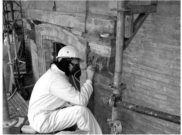
Figura 6. Limpieza láser en el Tambor de los Desamparados de Valencia
