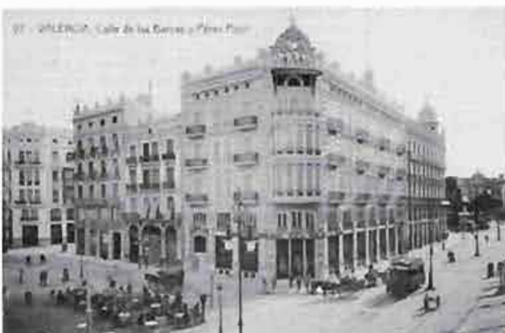
44. Solar resultante del derribo del Barrio de Pescadores, hoy ocupado por el Banco de España. Calle Las Barcas
