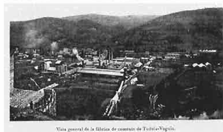
Vista general de la fábrica de cemento de Tudela-Veguín.
