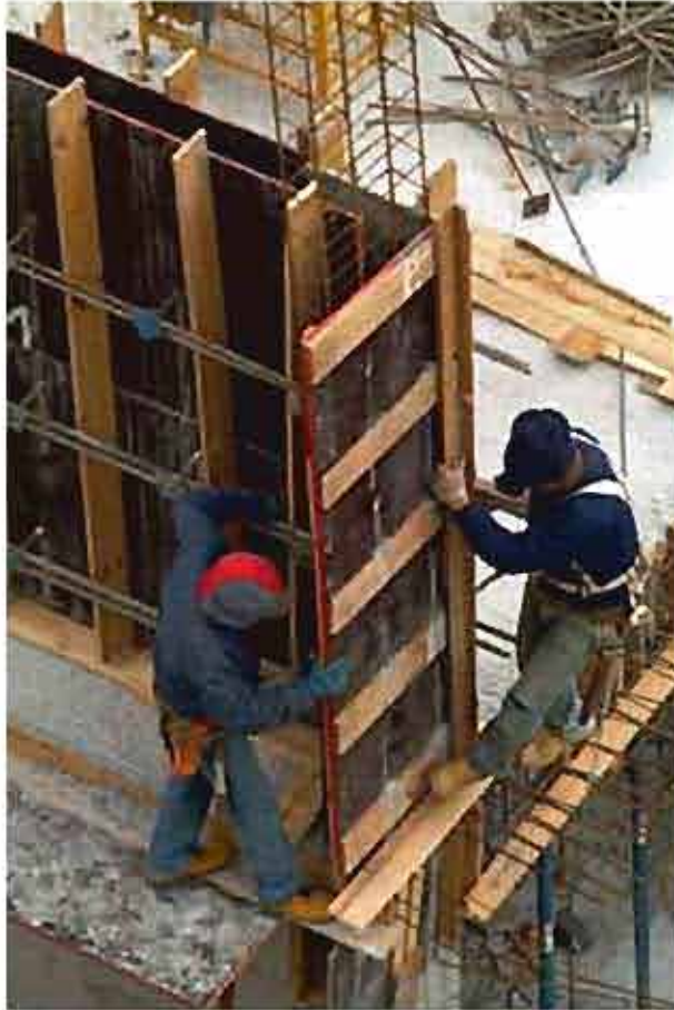
4. Encofradores nivelando tableros para el fundido de un muro de hormigón armado
