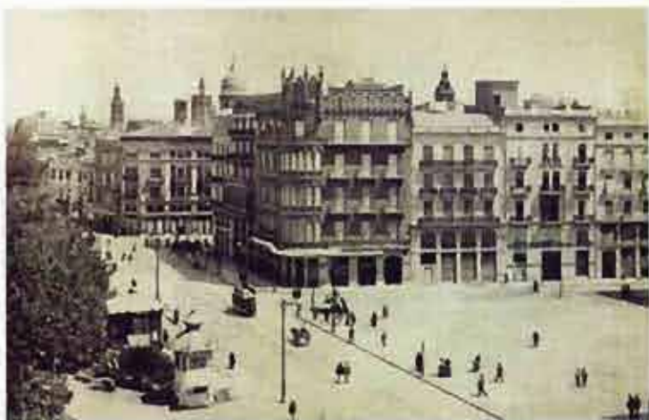
Derribo del Barrio de Pescadores. Gracias al cual se nos entregaron las plazas así y como hoy se encuentran. Se les ocupó en la actualidad por el edificio de Comercio y Telégrafos.
