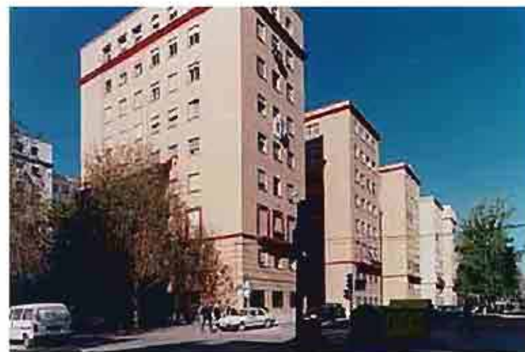
103. Edificio residencial con ordenación abierta (1947-1966). Grupo residencia en Jaime Roig, arquitectos GO-DB arquitectos, 1962
