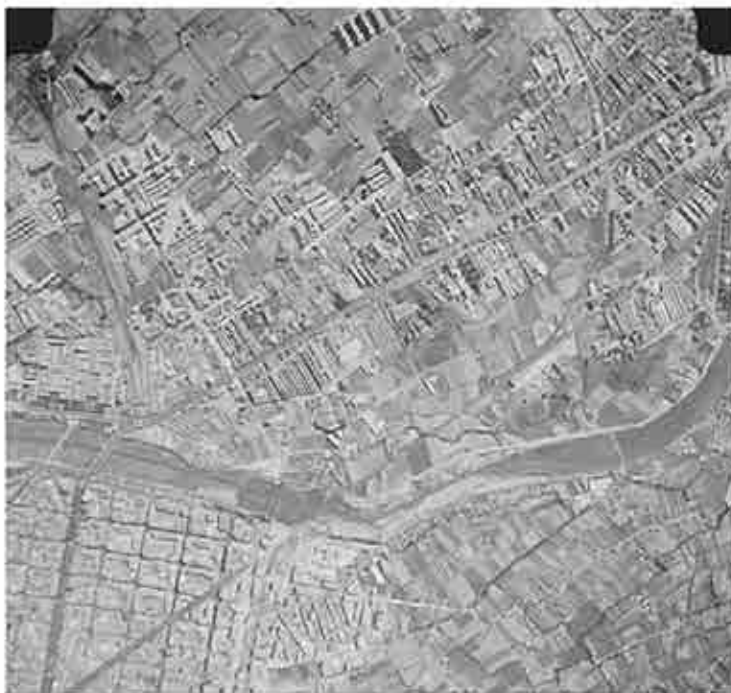
51. Fotograma de los crecimientos desarrollados en torno a la Avda. del Puerto. 1957 y 1964
