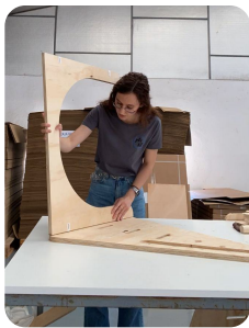
Fig 84. Colocación del refuerzo. Elaboración propia.
