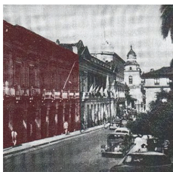
Figura 32 Casa a expropiar junto al antiguo edificio del Palacio Municipal
