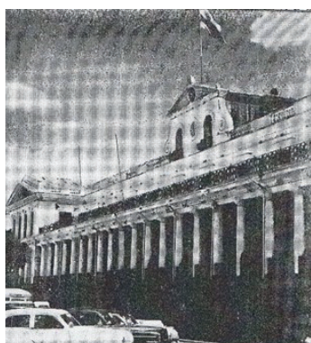
Figura 26 Fachada Palacio de Gobierno.
