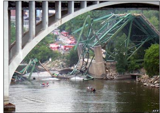
Figura 1.11: Ejemplos de colapso debido a una resistencia insuficiente: a la derecha, colapso del puente de la I35W sobre el Mississippi en Minneapolis, el 1 de agosto de 2007
