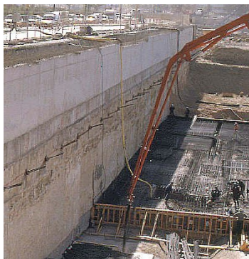
Contención mediante un muro-pantalla
