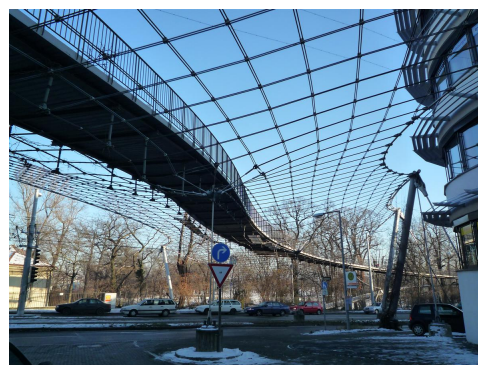
Pasarela en Löwentor (Stuttgart) (Schlaich, Bergermann und Partner, 1992)
