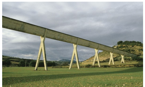
Acueducto de Alloz (Torroja, 1940)
