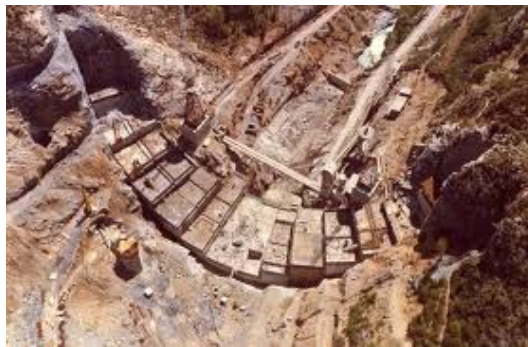
Figura 1.8: Presa en construcción. Obsérvese el volumen de los segmentos de la presa, que finalmente conformarán un único elemento estructural masivo
