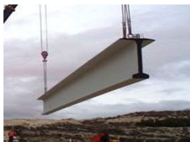
Viga en doble T de hormigón pretensado
