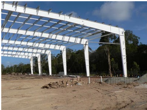
Figura 2.6: Pórticos en una nave industrial y entramado en una estructura de edificación
