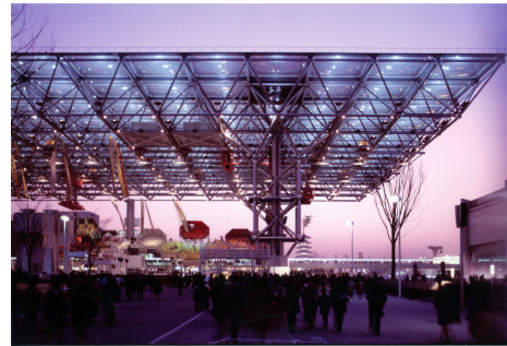
Malla espacial en la Expo de Osaka (Arq. Isozaki, Ing. M. Kawaguchi, 1968)
