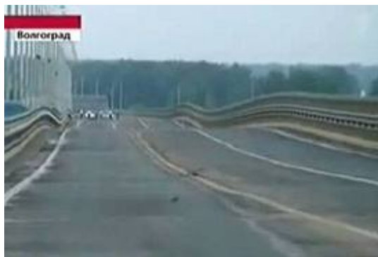
Figura 1.12: Pérdida de funcionalidad debido a una rigidez insuficiente: vibraciones inducidas por el viento en un puente sobre el Volga el 21 de mayo de 2010
