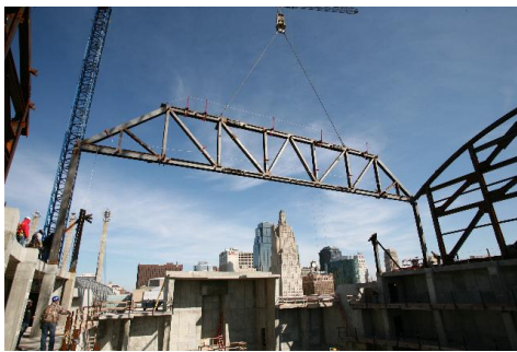
Montaje de una cercha en un edificio industrial
