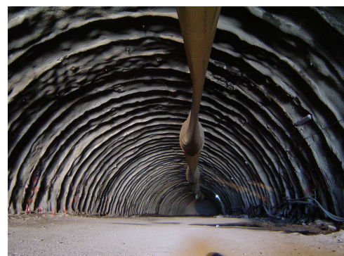
Sostenimiento de un túnel
