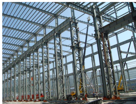
Figura 1.5: Estructura para un edificio industrial
