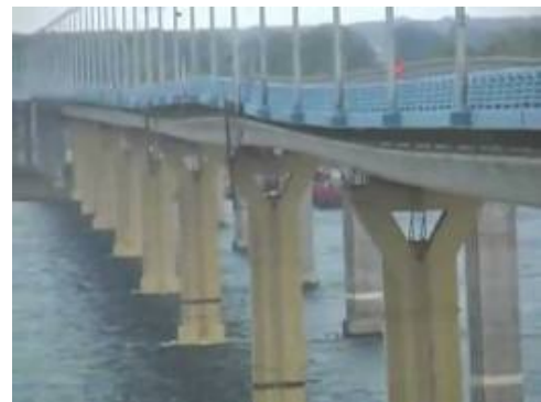
Figura 1.12: Pérdida de funcionalidad debido a una rigidez insuficiente: vibraciones inducidas por el viento en un puente sobre el Volga el 21 de mayo de 2010
