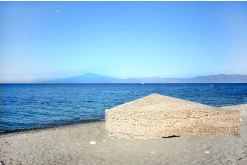
Fig. 4- Lazzaro-Motta San Giovanni (Reggio Calabria), veduta di una casamatta (Maria Rossana Caniglia, 2022)
