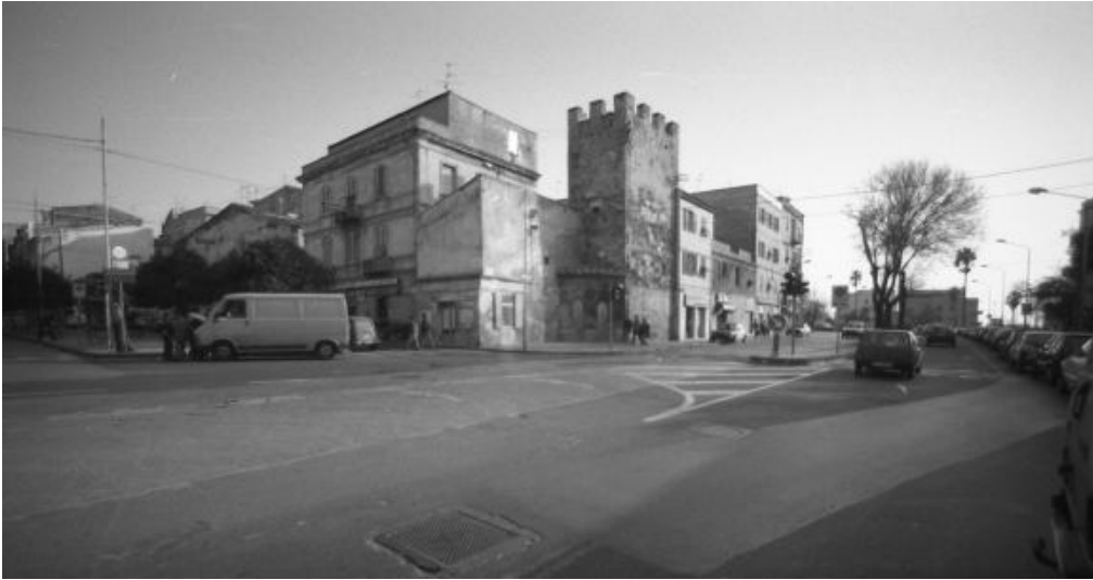
Fig. 3- Sassari, Mura urbane nord nei pressi di piazza S. Antonio, resti di fortificazioni inglobate nel fronte edilizio (Archivio SABAP SS, negativo C.S. 07)
