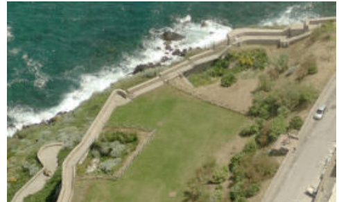
Fig. 13- Terrapieni seicenteschi emersi a seguito degli scavi archeologici nell'area degli "spalti Manganella" (RAS 2008)
