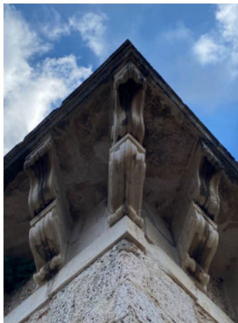
Fig. 11- Roccavaldina (Me), Palazzo baronale, particolare del prospetto nord-ovest (Francesca Passalacqua, 2022)
