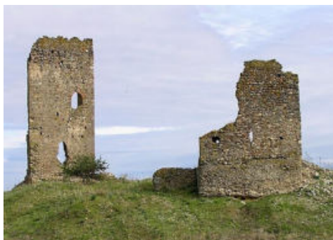
Fig. 3- Spezzano Albanese: resti del castello di Scribla (foto di B. Canonaco)
