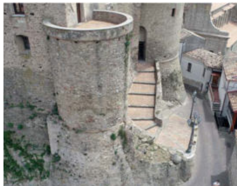
Fig. 3- Castello di Oriolo, accesso principale
