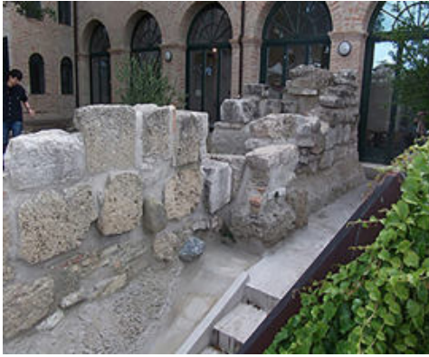
Fig. 2- Muratura a grandi blocchi, di epoca romana, all'interno del cortile di Palazzo Battiferri (Foto di Alessandra Cattaneo)
