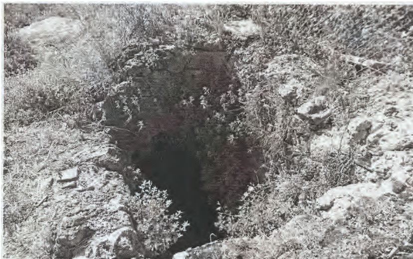
Figura 4. Accés a carcau? (ant. parcel·la 109).
