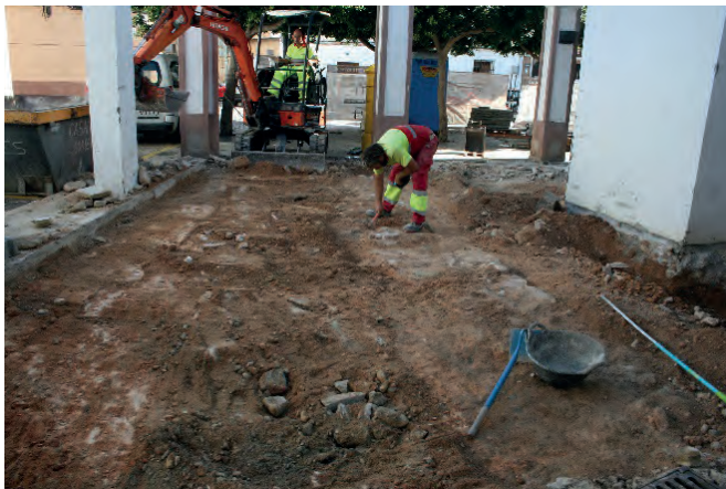
Figura 5. Inici de la delimitació dels fonaments de manera manual.
