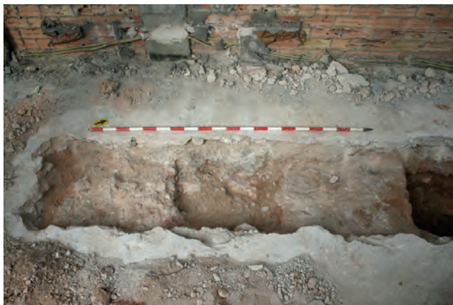
Figura 18. Detall del doble fonament de la façana lateral oest de l'església baixmedieval descobert en la rasa de comprovació efectuada davant de la façana principal de l'ajuntament.
