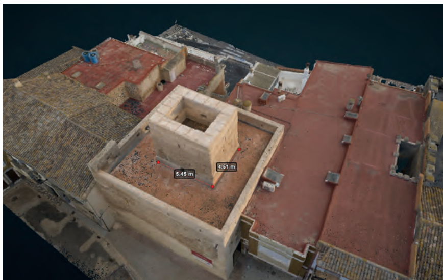
Figura 2. Torre d'Alfarb. Medició amb visor científicotècnic 3D PointBox AD&D 4D.
