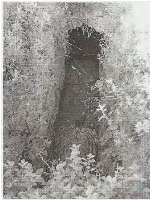
Figura 3. Accés a carcau? (parcel·la 108).
