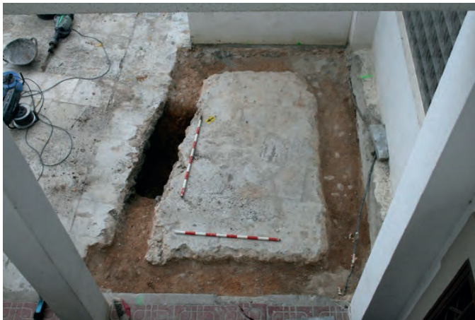
Figura 3. Excavació manual de riostes en la zona que s'establí com a sondeig.
