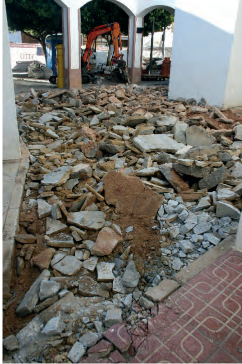
Figura 4. Aspecte dels solar després d'haver picat el soler de formigó contemporani.
