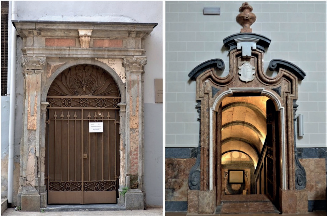
Fig. 9. Puertas de acceso al Panteón desde el exterior y desde el interior de la Iglesia. Fotos: Autor.
