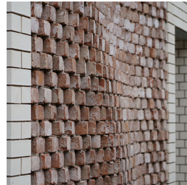
Fig.61 Posibilidades constructivas mediante el casco inteligente DAQRI.
