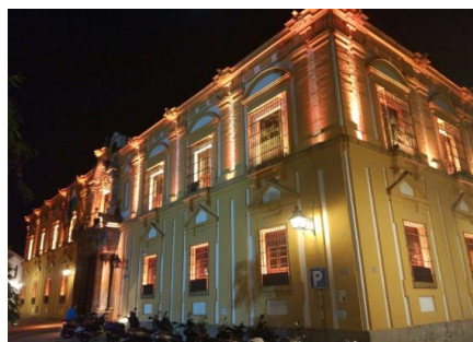
Fig. 3. Vista general del edificio objeto del concurso con las luminarias utilizadas
