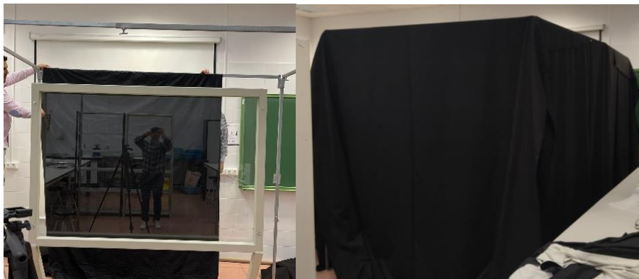
Fig. 5. Colocación de estructura de cerramiento y cubrimiento del Lighboard studio.
