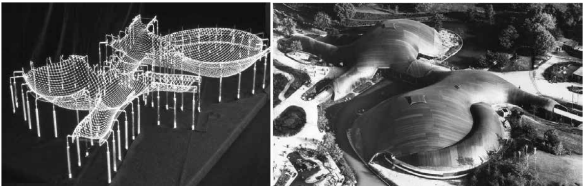
Figura 5. Pabellón de Instituto de Estructuras Ligeras (IL) en la Universidad de Stuttgart (a) Modelo de lámina de jabón con un solo lazo de cuerda. (b) La red de cables en construcción. (Imágenes: Berthold Burkhardt)
