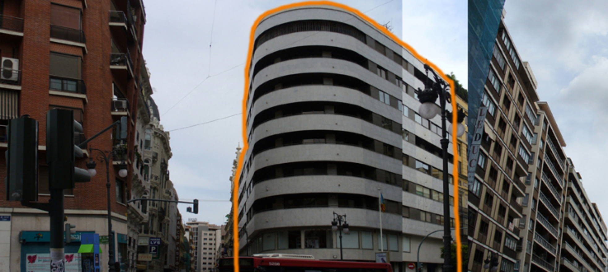
Edificio en Colón, 1970 (junto a Román Jiménez).
