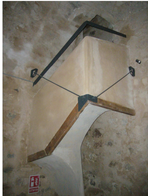
Fig. 10. Acabado final del giro de la escalera de acceso (Autor, 2018).
