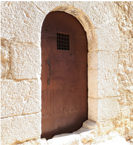
Fig. 5. Puerta acabada, protegida con lámina de acero (Autor, 2018).
