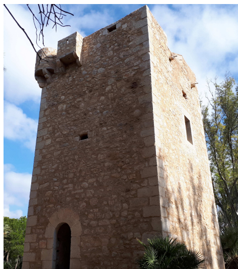
Fig. 2. Ángulo sur después de la intervención de 2018 (Autor, 2018).
