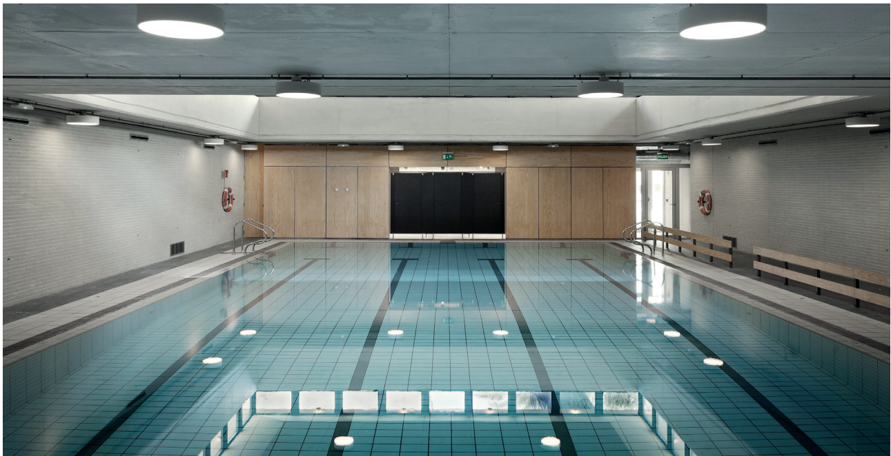
Figure 8. View of the concrete slab above the water surface. 2019. ©Enrique Cabezadevaca / Figura 8. Vista de la losa de hormigón sobre la lámina de agua. 2019. ©Enrique Cabezadevaca.
