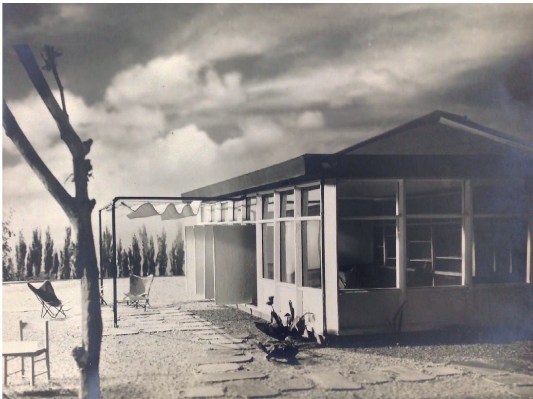
Figura 2. Sistema BGB. Maqueta. 1949. Detalle de la subestructura, toldo y paneles giratorios. Imagen inédita.
