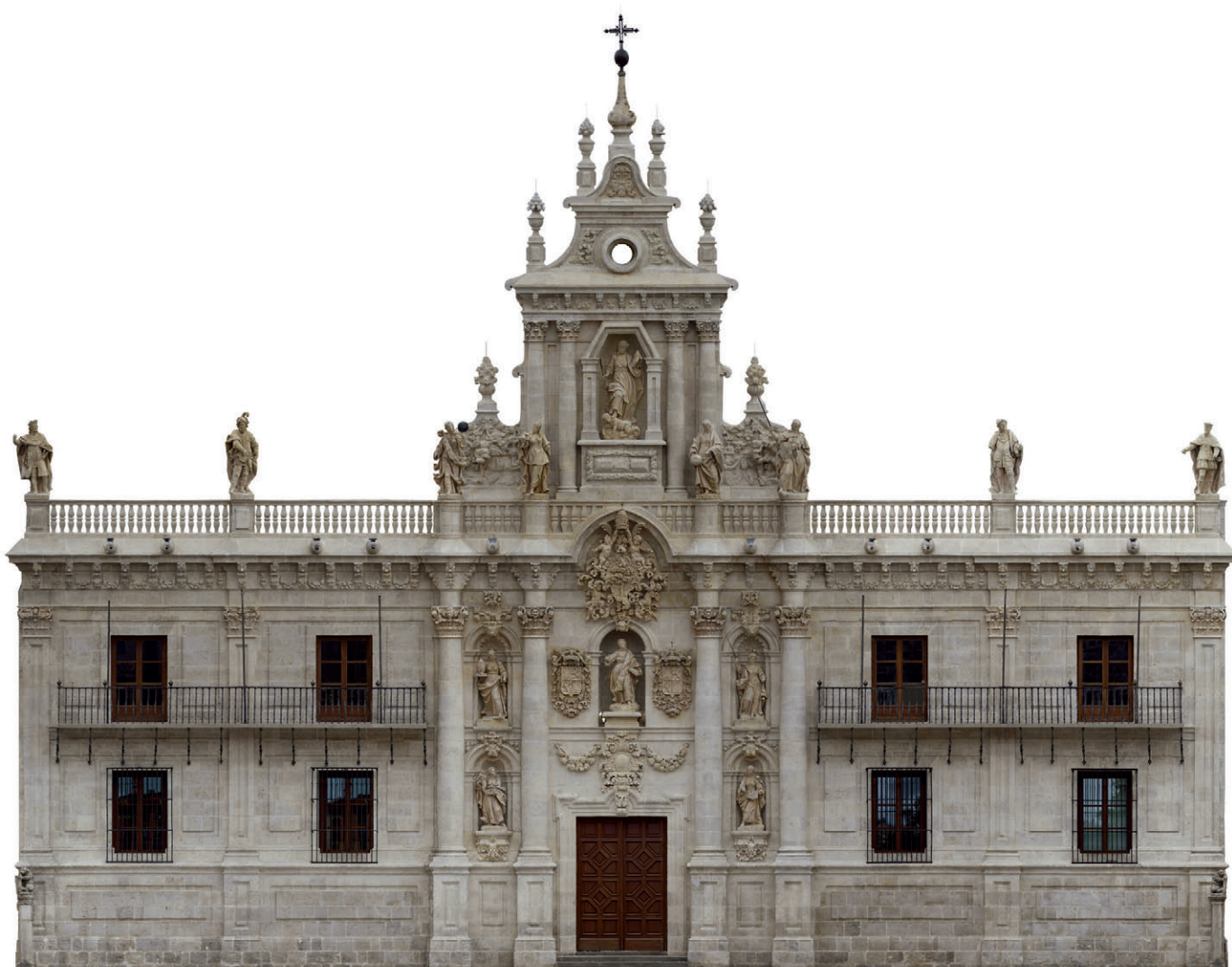
PARTE DELANTERA FACHADA RESTAURADA Mayo 2015
