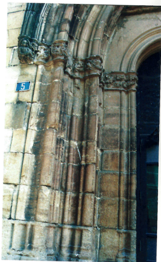
14. Portada Norte. Humedades en las arquivoltas. Zonas arenizadas y restos de pátinas.
