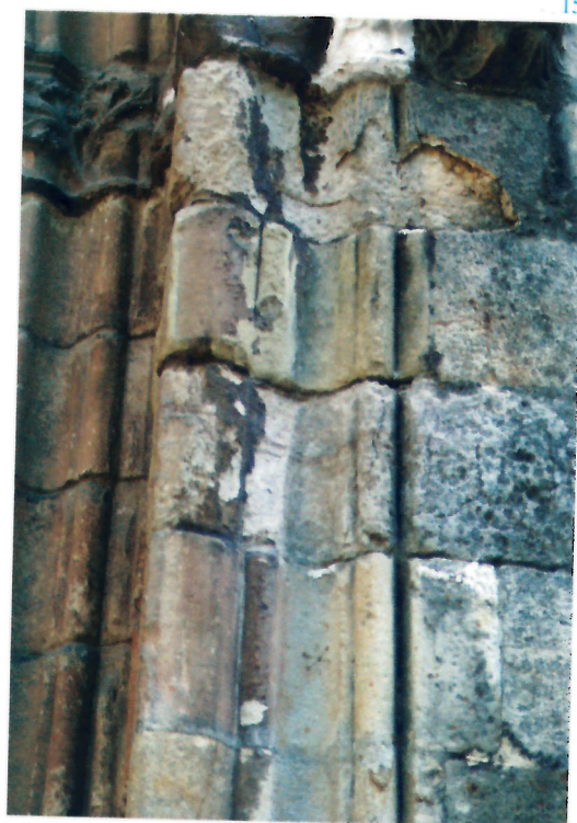
15. Portada Norte. Deplacados y arenizaciones
