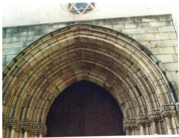
13. Roca disgregada; piedra arenisca de 1940: juntas descarnadas; restos de pátina, ampolladuras ocasionales; colonias biológicas; pérdidas de piedra por fracturas.
