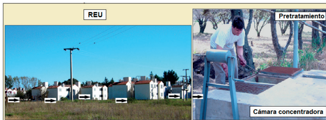
Figura 1 | Captación de agua residual y área de pretratamiento.
