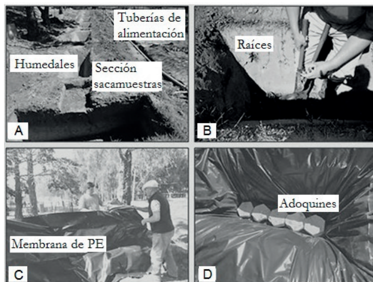
Figura 3 | Secuencia de pasos en la instalación de humedales.
